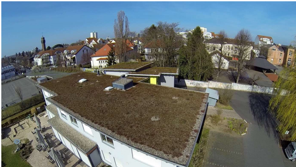
Abb. 9: Das ZenJA mit seinem Gründach. Im Vordergrund Abschnitt 1 dahinter Abschnitt 2
