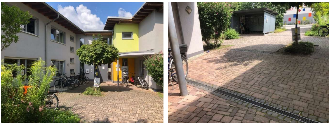
Abb.12: Der Zugang zum Haupteingang des ZenJA fällt zum Gebäude hin ab (links). Es gibt ein kleines Gegengefälle mit Ablaufrinne unmittelbar vor dem Eingang (rechts)
